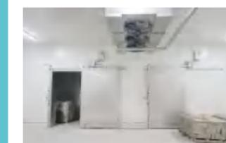
من المحتمل أن تظهر الرطوبة على باب المستودع ذو درجة الحرارة المنخفضة، لذلك يتم استخدام الباب المصنوع من الفولاذ المقاوم للصدأ لحماية الباب من الصدأ بسهولة.
